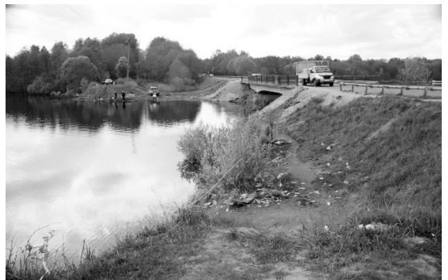
Salmen silta Lempaalassa vuonna 1911 ja 2012. Kuvat Samuli Paulaharju ja Arvo Iho.
